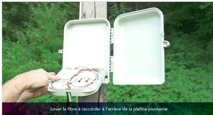
Lover la fibre à raccorder à l'arrière de la platine pivotante
