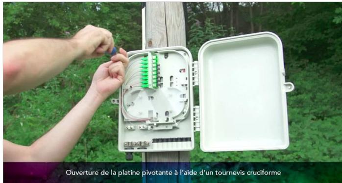
Ouverture de la platine pivotante à l'aide d'un tournevis cruciforme
